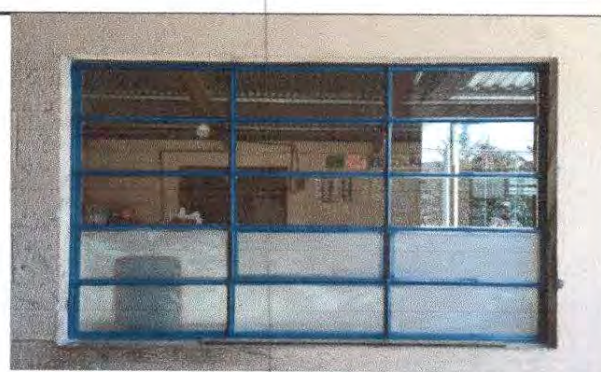
Foto 4: sustitución de ventanas de madera por metal mas vidrio en el modulo 1 del Edificio Escolar
