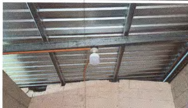
Foto 2: sustitución de estructura de soporte de madera por metal en el corredor direccion y dos bodegas del Edificio Escolar
