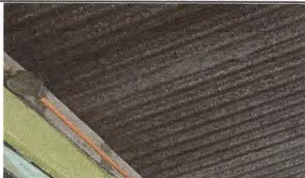
Foto 13: Sustitución de ducto eléctrico y accesorios en todo el modulo 1 y 2 aulas del modulo 2 del Edificio Escolar
