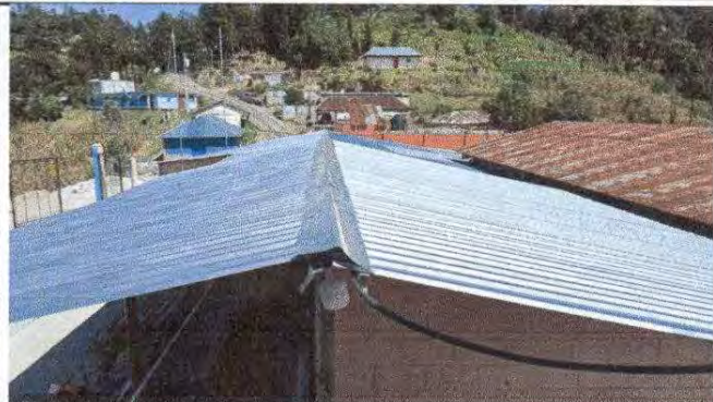
Foto 1: Sustitución de lamina por lámina troquelada aluzinc calibre 26 del modulo 1 del edificio Escolar
