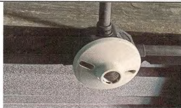
Foto 8: sustitución de plafoneras en todo el Edificio Escolar
