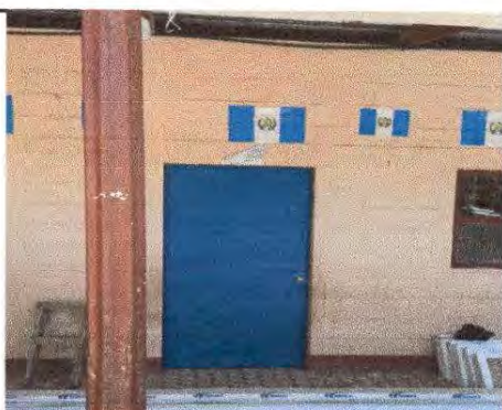
Foto 3: sustitución de puertas en el modulo 1 del Edificio Escolar
