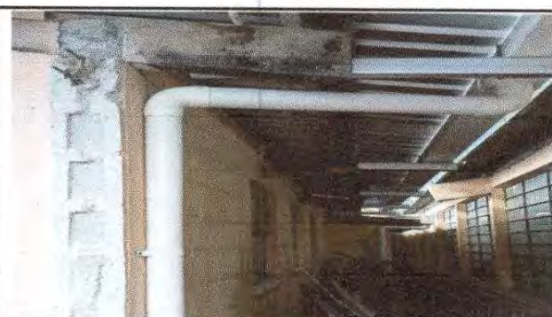
Foto 6: bajadas de agua pruvial de metal por tubo PVC en la parte frontal y trasera del modulo 1 del Edificio Escolar
