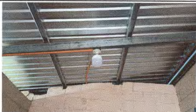
Foto 7: Sustitución de focos ahorradores en todo el Edificio Escolar
